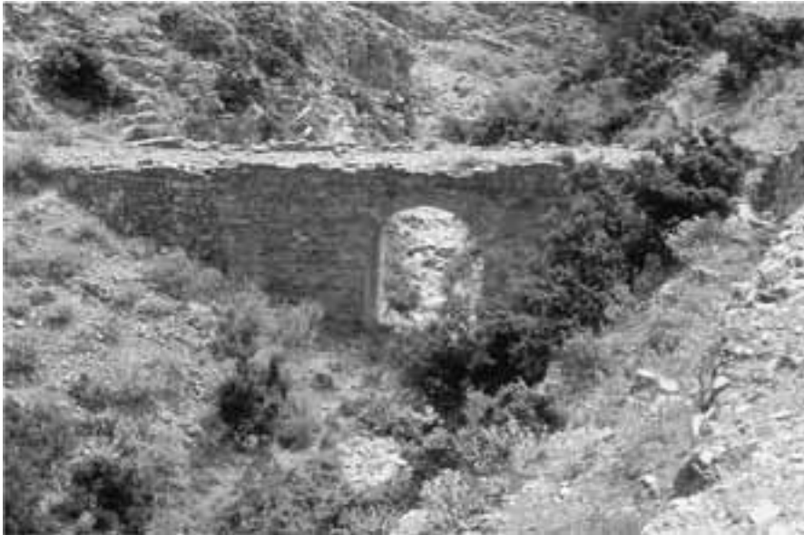
Εικόνα 19 Γέφυρα στο «Κακόροεμα» πάνω στο μονοπάτι από τις Γλαφυρές προς τον αρχαίο οικισμό του «Παλαιοκάστρου»-Βοΐβη (?)
