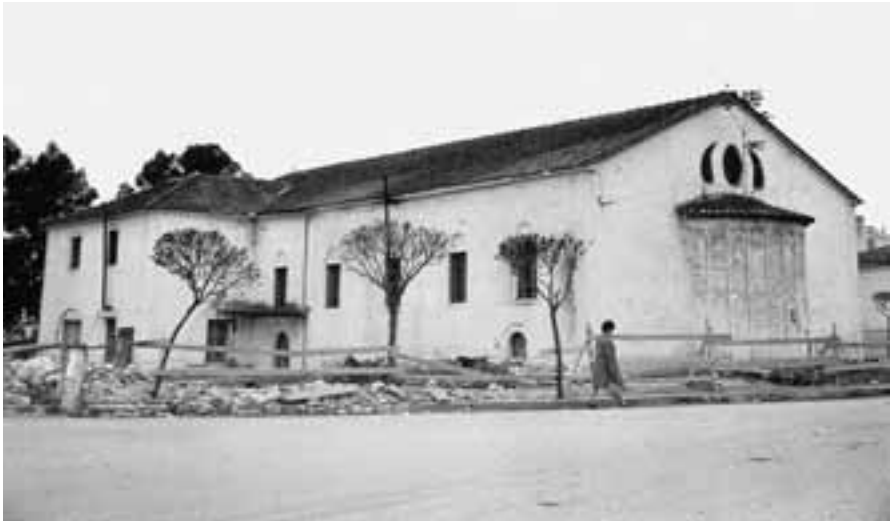
Εικ. 6. Λάρισα, Άγιοι Τεσσαράκοντα, 1862-1866. Κατεδαφίστηκε 1977 (Φωτογραφία του 1966 κατά ιδιόχειρη παραχώρηση (29.09.1992) Δημ. Τλούπα, Νο Φωτο. C.706).
