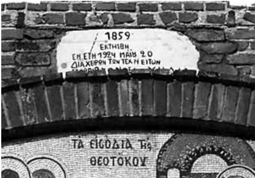
Εικ. 12. Ελασσόνα, Βαρόσι. Δυτική όψη καμπαναριού ναού Εισοδίων. Η κτητορική του επιγραφή του 1924 (φωτ. Κ. Μπίσιμπα).
