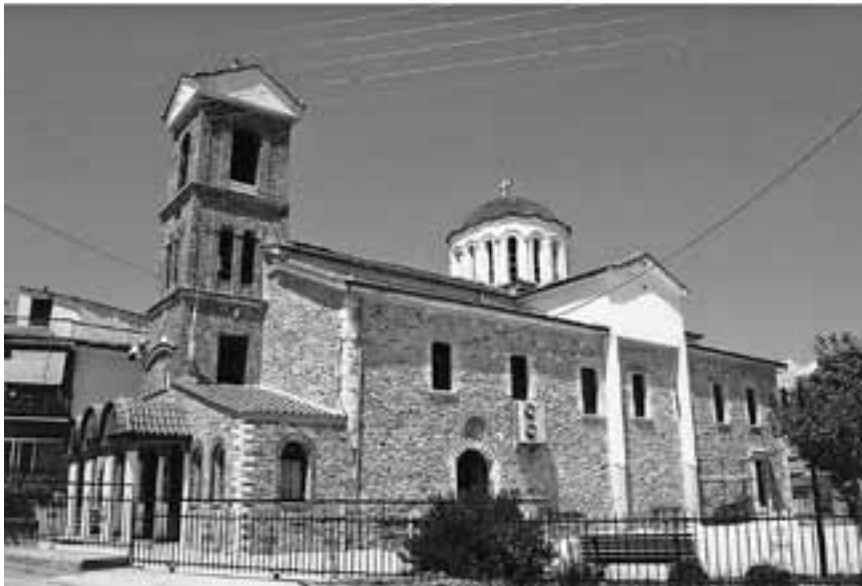
Εικ. 10Α & Β. Ελασσόνα, Βαρόσι. Εισόδια. - Α. (επάνω): ΒΑ άποψη. Στην ανατολική πλευρά οι αχλαδόσχημοι φεγγίτες του 1859. Στη βόρεια εμφανίζονται οι μπετονιένες κολόνες που συμμετέχουν στη στήριξη του τρούλλου του 1965. - Β. ΝΔ άποψη. στη νότια πλευρά οι αντίστοιχες κολόνες, που υπάρχουν στο βορρά, στη δε δυτική το κωδωνοστάσιο (Φωτογραφίες Κ. Μπίσιμα).
