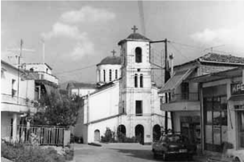
Εικ. 11. Ελασσόνα, Βαρόσι. Εισόδια. Κωδωνοστάσιο στη δυτική όψη, κτίσμα 1924 (φωτογραφία χ.χ.).
