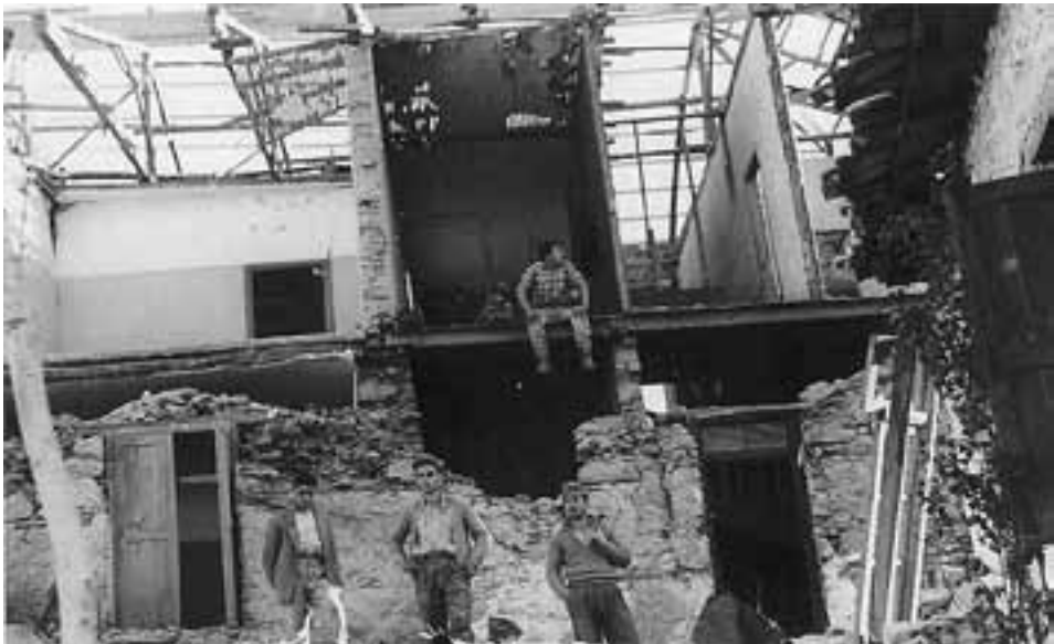
Μετά το σεισμό άρχισε η κατεδάφιση των σπιτιών.
