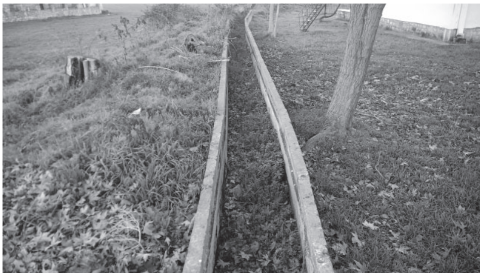
Εικ. 4. Κεντρικός τσιμενταύλακας, πίσω από το Κτηνιατρείο (εσωτερικό πλάτος 0,76 εκ και ύψος 0,76 εκ), όπως είναι σήμερα (2021).
