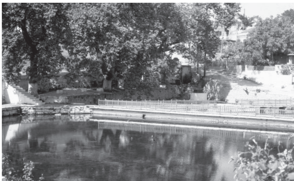
Εικ. 8. Η Υπέρεια Κρήνη γύρω στο 1990. Άποψη από Α.
