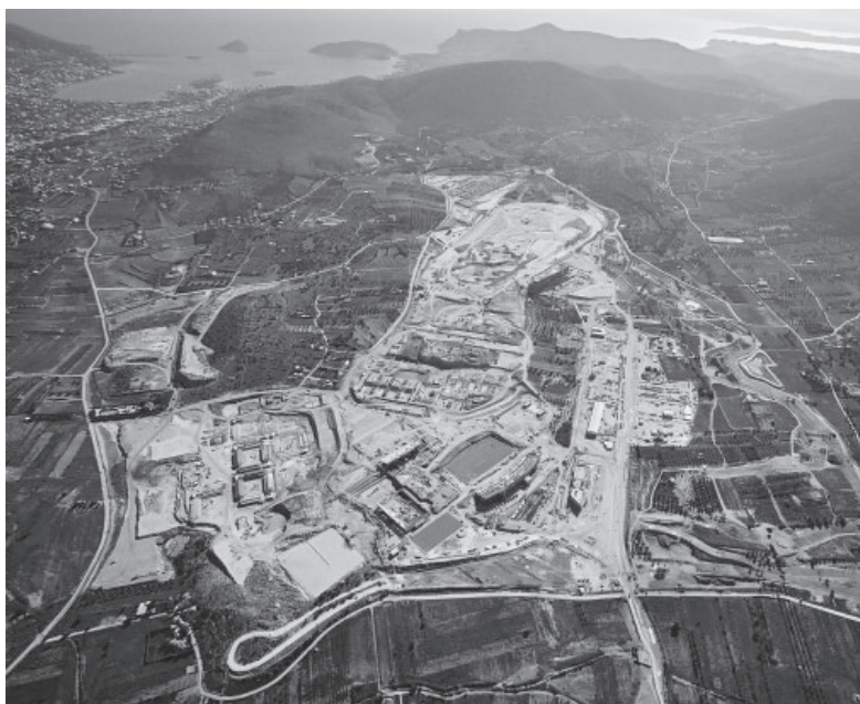
4. Μερέντα, ο χώρος κατασκευής του ΟΙΚ και του Ιπποδρόμου.
