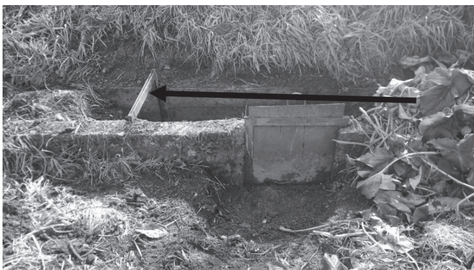
Εικ. 7. Κίνηση νερού στο αυλάκι, κόφτρα κλειστή προς χωράφι, όπως είναι σήμερα (2021).
