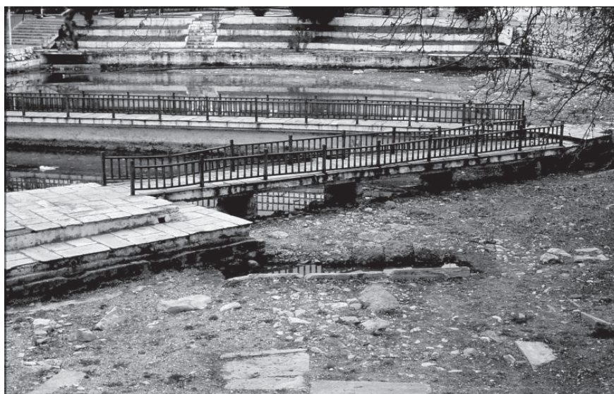
Εικ. 9. Η Υπέρεια Κρήνη γύρω στο 1998-1999, λίγο πριν από την οριστική απώλεια των υδάτων της. Άποψη από ΒΔ.
