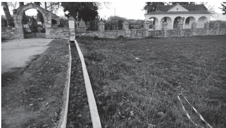
Εικ. 6. Αυλάκι μπροστά στον Ιερό Ναό του Αγίου Μηνά (εσωτερικό πλάτος 0,45 εκ και ύψος 0,45 εκ), όπως είναι σήμερα (2021).
