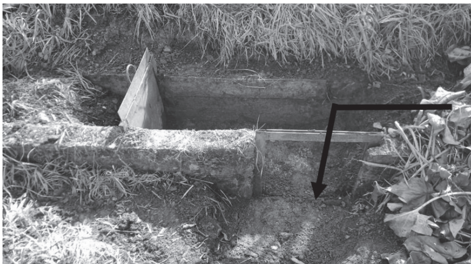
Εικ. 9. Κόφτρα κλειστή στο αυλάκι, κίνηση νερού προς χωράφι, όπως είναι σήμερα (2021).
