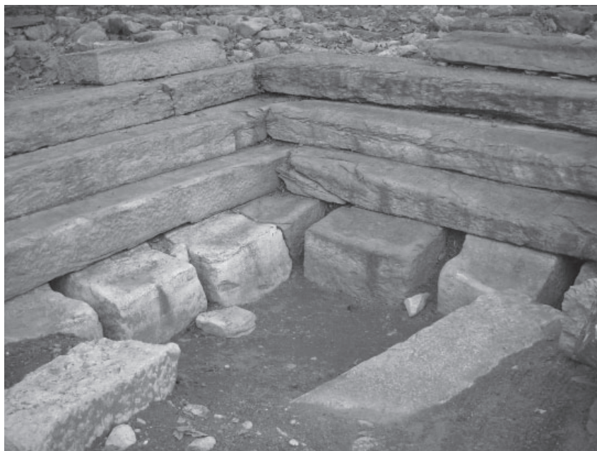
Εικ. 20. Υπέρεια Κρήνη Φερών. Η κλίμακα καθόδου στο εσωτερικό της δεξαμενής του κρηναίου οικοδομήματος. Άποψη από Α.
